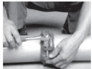
**Attenzione:** Il serraggio completo unilaterale di un dado potrebbe fare scivolare la guarnizione che si inserirebbe fra le ganasce della parte opposta del giunto.
