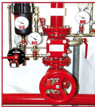
Stazione a secco TAV Dry station TAV
